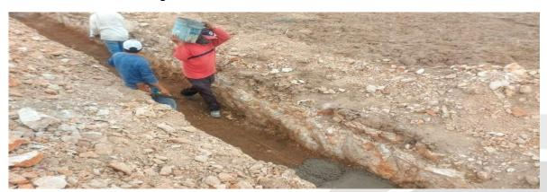
Muro de mampostería de piedra braza de la región asentada y juntada con mortero, cemento-arena prop .1.4
