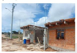
Se asistió a la primera supervisión de la obra denominada: "Ampliación de Electrificación, en Ocampo, Gto. Varias calles". Comenzando con Suministro y Colocación de poste de concreto reforzado 12 mts 750 kg/cm2 incluye excavación en material tipo III con compresor neumático, donde se observó que se excedió en las dimensiones de la excavación de pozos y esto puede afectar la resistencia de los postes.
