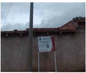
Supervisión de la obra denominada: Construcción de Barda Perimetral en Panteón San José, Ocampo Gto. donde actualmente se ejecuta el muro lateral de mampostería trapezoidal con un avance de 100m lineales, faltando 70m por construir.
